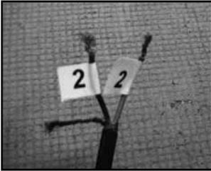
**8** Identifique con un número cada par de conexiones frías que provengan de una misma red. Coloque una pegatina con el número de cada par de cables cerca de su extremo.
